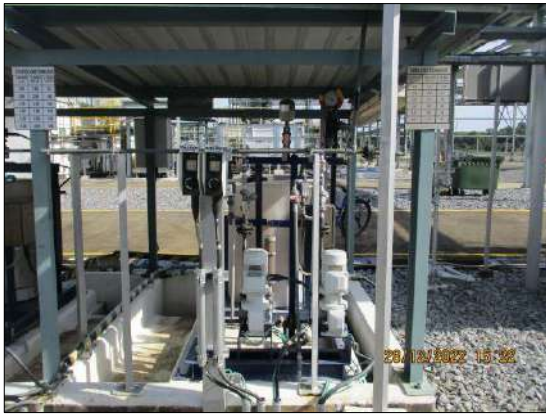
รูปที่ 2-23 การเติมสารเคมี Demulsifier ก่อนเข้าสู่ CPI เพื่อเพิ่มประสิทธิภาพในการแยกตัวของน้ำมัน หรือของแข็งออกจากน้ำเสีย
