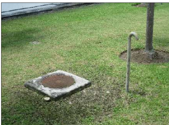
รูปที่ 2-21 ระบบ septic tank
