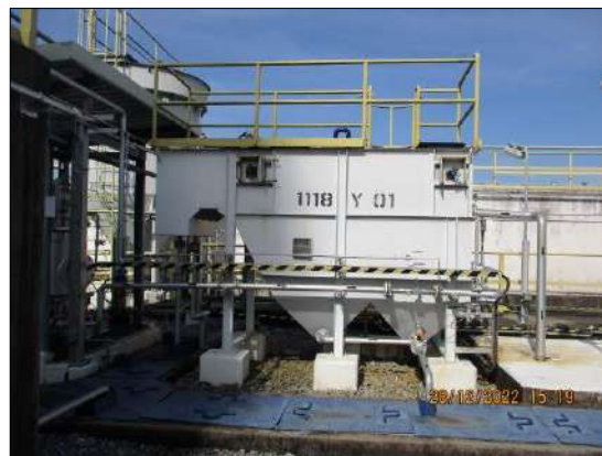
รูปที่ 2-18 หน่วย Flotation unit เพื่อให้น้ำมันที่เหลืแยกตัวออกจากน้ำ
