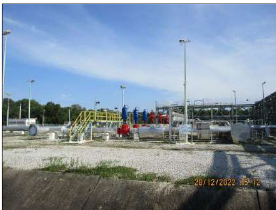
รูปที่ 2-13 ติดตั้งตัวปรับลดเสียง และฉนวนดูดซับเสียง ห่อหุ้มที่วาล์ว เพื่อให้ระดับเสียงอยู่ในระดับมาตรฐาน
