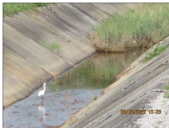
รูปที่ 2-20 รางระบายน้ำฝนที่ตกภายนอกพื้นที่ กระบวนการผลิตซึ่งไม่มีการปนเปื้อน
