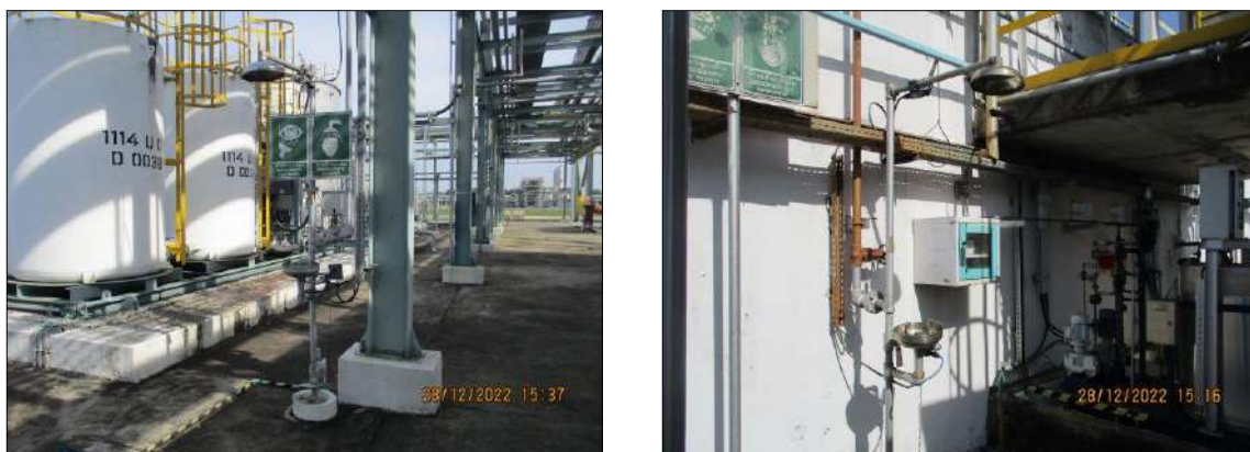
รูปที่ 2-50 ติดตั้งฝักบัวฉุกเฉิน ที่ล้างตาฉุกเฉิน บริเวณโรงแยกก๊าซธรรมชาติ ไทย-มาเลเซีย
