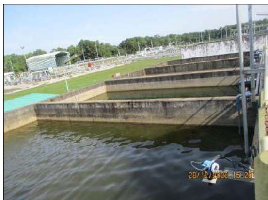
รูปที่ 2-16 บ่อตรวจสอบคุณภาพน้ำ จำนวน 4 บ่อ ขนาดความจุบ่อละ 360 ลูกบาศก์เมตร
