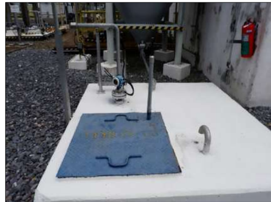
Recovered oil sump สำหรับเก็บรวบรวมกากตะกอน
