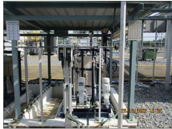
รูปที่ 2-24 การเติมสารเคมี Flotation agent เพื่อเพิ่มประสิทธิภาพในการแยกน้ำมันที่เหลื ออกจากน้ำ
