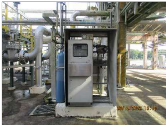
รูปที่ 2-59 Online Mercury Analyzer ที่ทางออกของหน่วยกำจัดปรอทที่โรงแยกก๊าซ
